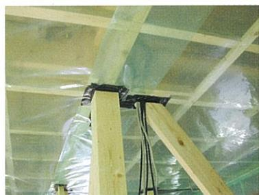
計画的に換気を行うためには気密性能を高め空気の出入口を限定することが大切です
