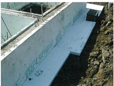
床下が新鮮空気の取り入れ口となるため基礎断熱仕様とし、床下の防腐処理などは必要最小限にとどめ、地盤の防湿についても土間コンクリートなどで完全におこないます
