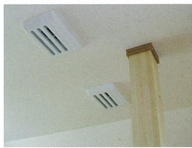
室内排気口には室内の湿度を感じて開閉するタイプのものを使用すると、不在時の過度な換気を防いでくれます
