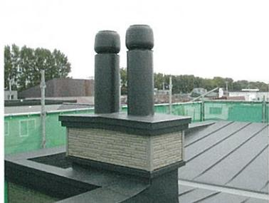
排気口は屋根最上部に上向きに取り付けるのが一般的です
