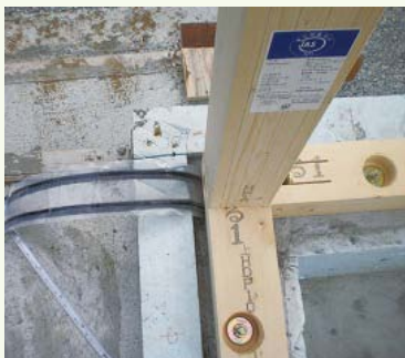
基礎断熱による基礎と土台の気密
