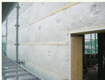
壁の断熱材（壁厚 200mm）
