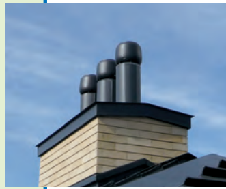
⑧パッシブ排気筒：鳩小屋方式(左)と断熱排気筒方式(右)
