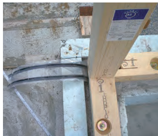
基礎断熱及び基礎と土台の気密
