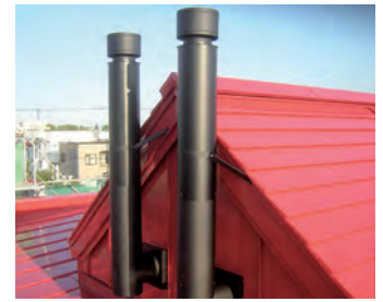
⑧パッシブ排気筒：鳩小屋方式(左)と断熱排気筒方式(右)
