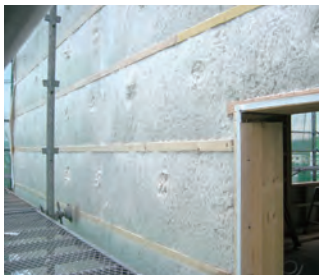
壁の断熱材(壁の厚さ200mm)
