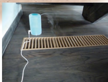
⑥ダウン開口の床ガラリ (空気が床下へ落ちている)
